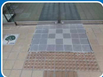
破損した正面入口の泥落としに代えて、滑り止めになるようにタイルを敷きました。
